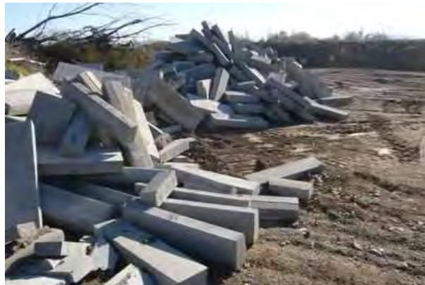
Zone d'accueil et de recyclage des matériaux inertes
